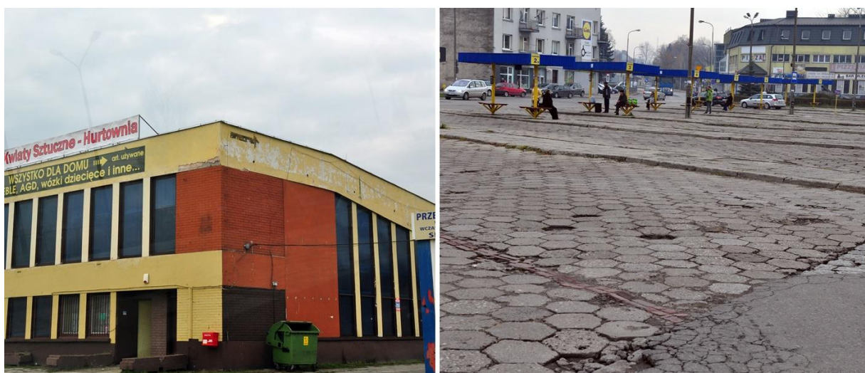
Ryc. nr 27. Dworzec PKP Starachowice Zachodnie oraz stanowiska autobusowe na Starachowicach Dolnych.
